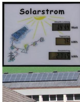
Anzeigemodul und Photovoltaikanlage
