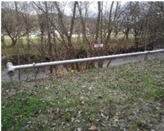
Bedingt durch die neuen Hochwasserschutzbauten entlang der Pitten war es notwendig, zwei Saugrohre für die ungehinderte Entnahme von **Löschwasser** zu stationieren. Eines beim Steg vom Rathausplatz in
