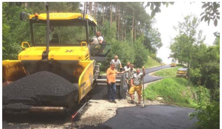
In Zusammenarbeit mit der Güterwegebauabteilung wurde ein weiteres Teilstück des **Güterweges Steinbruchweg** neu asphaltiert. Die Asphaltierungsarbeiten beim **Generationenweg** werden im Sommer umgesetzt. Hier ist es notwendig, die Anbindung an die Markstraße bei der Nestlé-Brücke flacher zu gestalten. Weiters sind Verkabelungsarbeiten für eine Beleuchtung durchzuführen und schattige Rastplätze zu schaffen.
